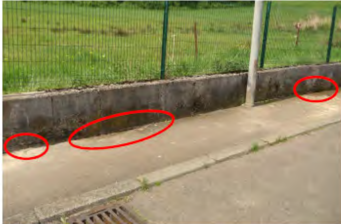
Abbildung 14: L'eau de surface traversant le mur
