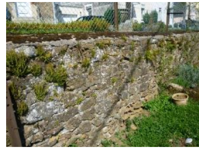
Photographie 3.9-5 : Trockenmauer in der Rue des Mines
