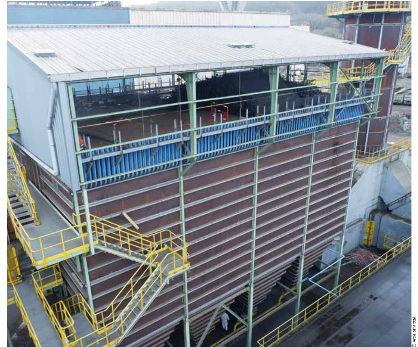
Démontage du système de dépoussiérage de Florange
