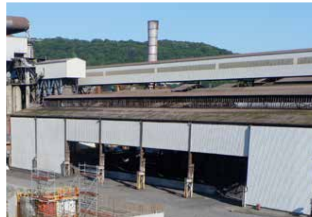
Nouvelle halle à scories
