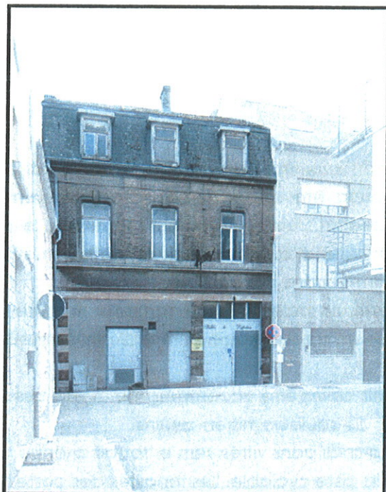
Façade rue Kelvert (N°4)
