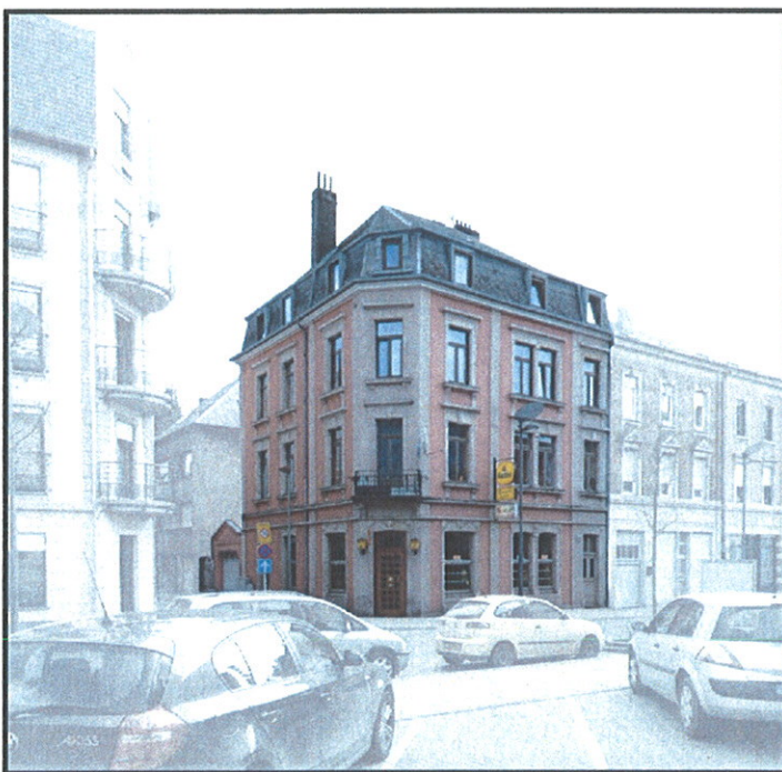
Façade Avenue de la Liberté (N°58)
