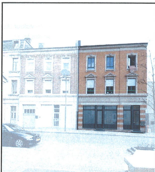
Façade Avenue de la Liberté (N°54)
