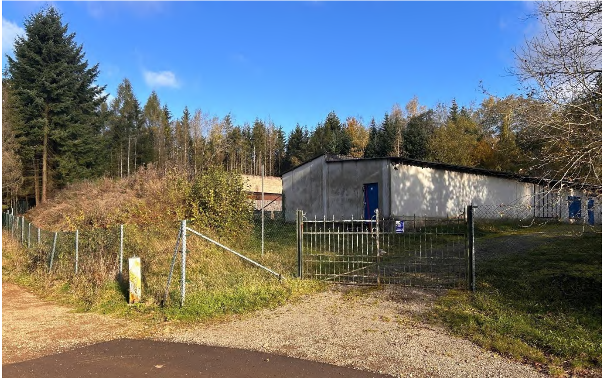
Abbildung 7: Blick auf das bestehende Gebäude und die Einfahrt aus südlicher Richtung, links: Wanderweg und leicht ansteigende Böschung; Hintergrund: angrenzendes, umliegendes Waldgebiet, welches in dem Bereich des Plangebiets überwiegend von Nadelgehölzen dominiert wird. Quelle: Oeko-Bureau, Oktober 2024
